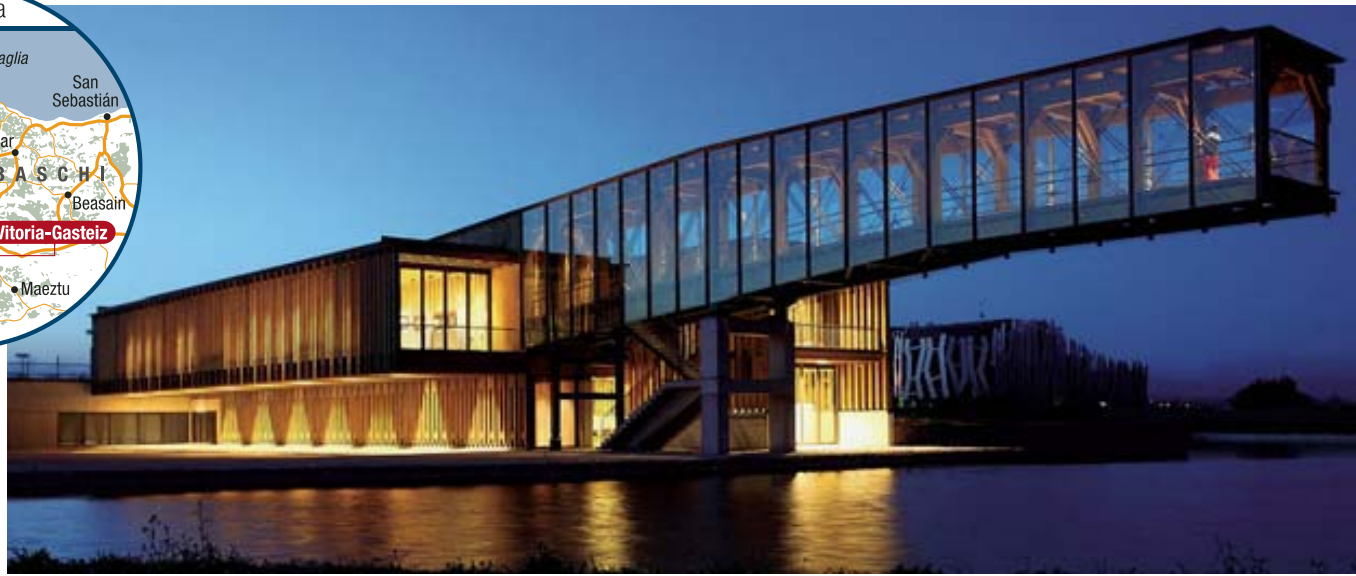
Avanguardia Un edificio «bio» costruito su uno specchio d'acqua a Vitoria-Gasteiz, nei Paesi Baschi, in Spagna. La città conta 240 mila abitanti (Foto Quintas)
